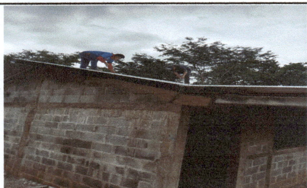
Foto 3: Reparación de muros de mampostería para dirección y bodega.
