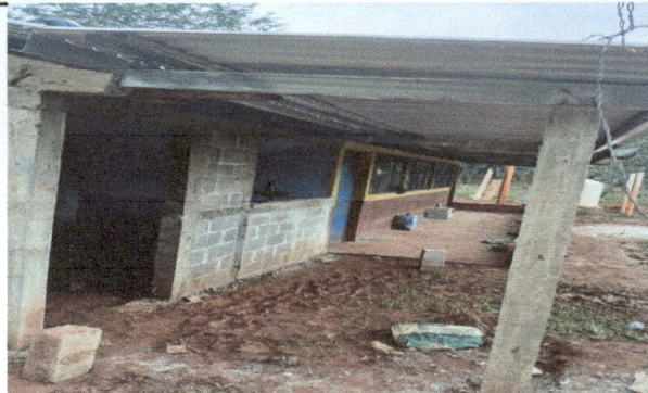
Foto 2: Cambio de abatimiento hacia afuera y pintura acabado de toda la escuela.
