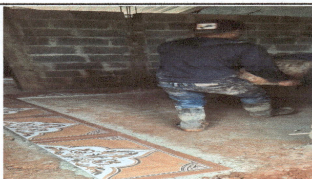
Foto 6: Sustitución de piso rústico por piso cerámico en aulas.
